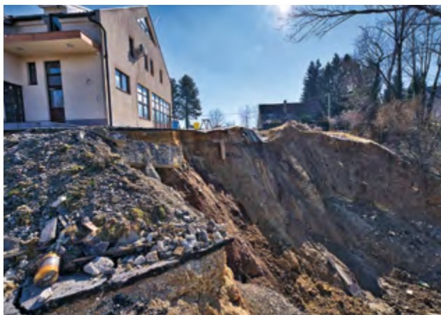
Klizište kod Huma na Sutli (foto: T. FRANGEN) Landslide near Hum na Sutli (photo: T. FRANGEN)
