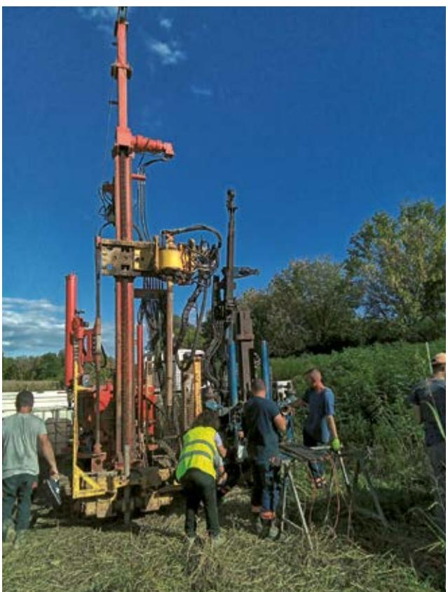
Istražno bušenje i geotehničko ispitivanje (foto: L. Wacha)
