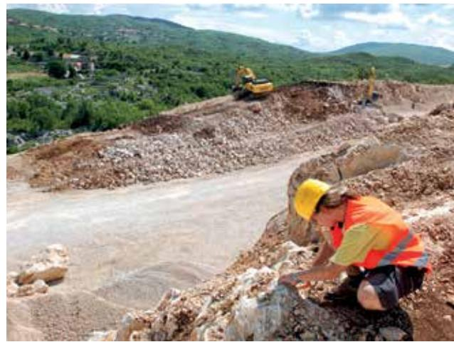
Inženjerskogeološka istraživanja za potrebe izgradnje autoceste (foto D. Navratil)
